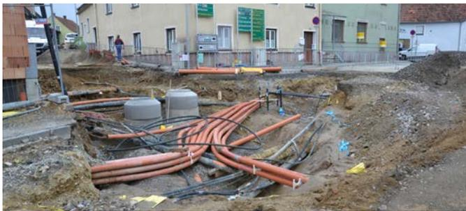
Im Bereich der Kreuzung wurden neben Kanal- und Wasserleitungsrohren auch zahlreiche EVN-, Post- und Fernwärmeleitungen verlegt.
