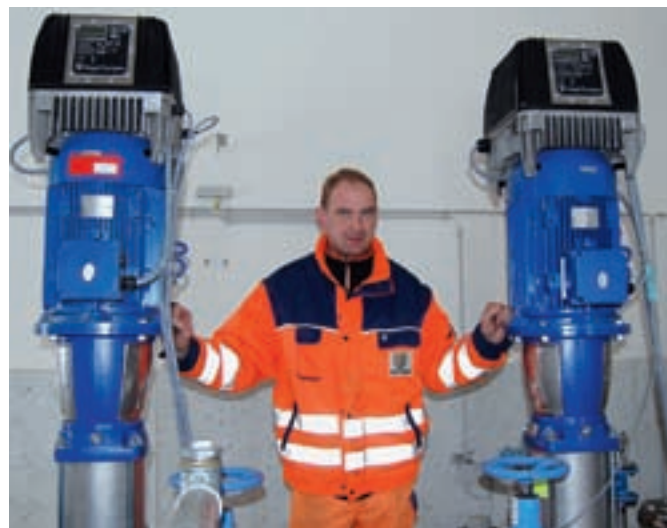
Im Tiefbehälter der Gföhler Wasserversorgung wurden zwei leistungsstärkere Pumpen eingebaut.
