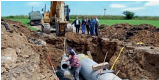
Im Zusammenhang mit dem Hochwasser-Rückhaltebecken wird ein neuer Kanalstrang in der Kudlichgasse verlegt.
